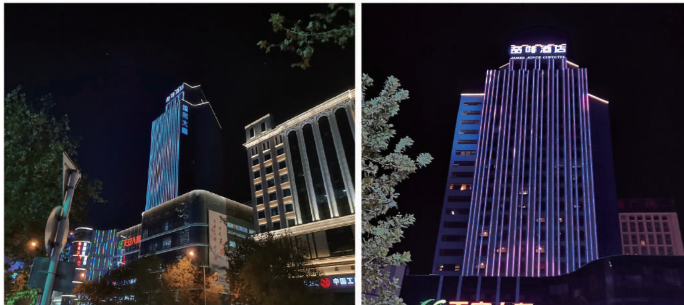
项目名称:石家庄中山路景观整治提升工程 开工日期:2019年11月
