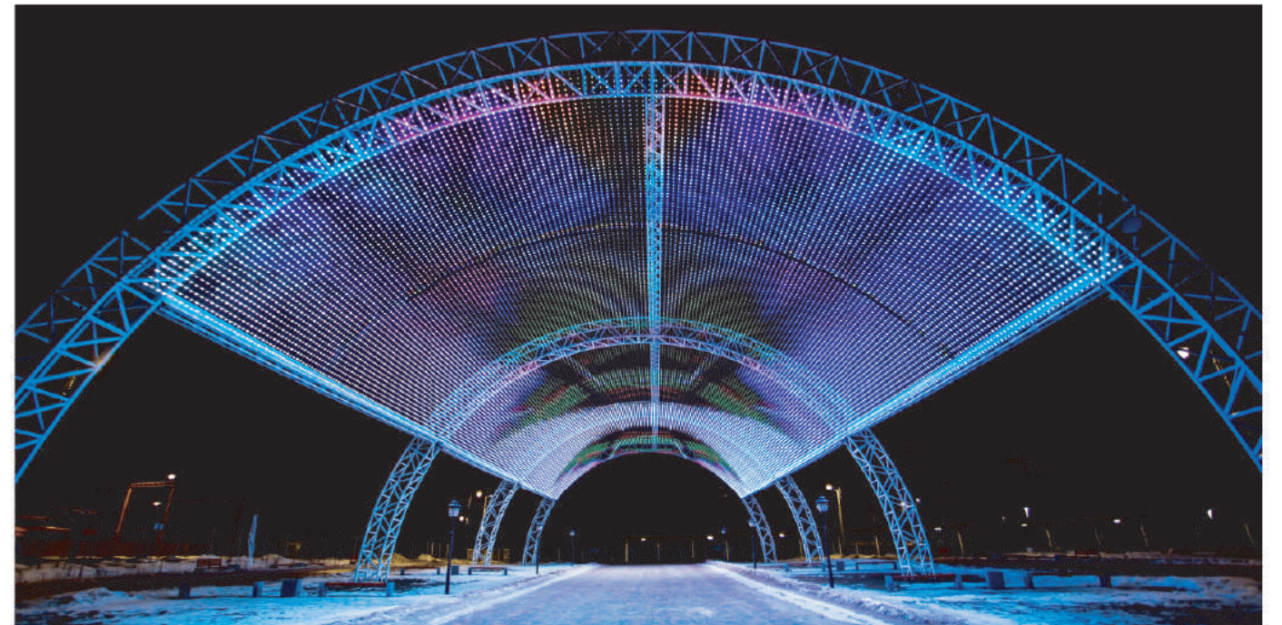
项目名称: 伏尔加格勒体育馆项目 开工日期: 2018年3月
